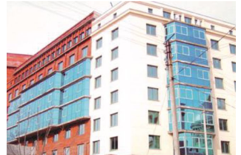
Объект: Жилое здание, г. Воронеж Поставщик: ПБЮЛ Сураев «Евросантехника»
