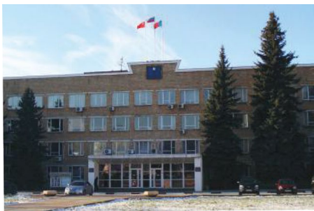
Объект: Здание администрации, г. Щелково Поставщик: ООО «Базис ТСС»
