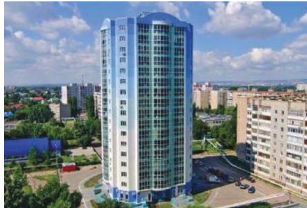
Объект: Монолитно-каркасный жилой дом, г. Энгельс Поставщик: ООО «Сантехкомплект»
